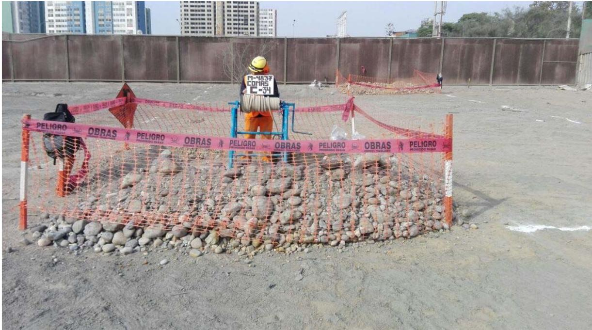
CALICATA C-34. SE APRECIA EL MATERIAL GRAVA ARENOSA EXTRAÍDA DE LA EXCAVACIÓN.
