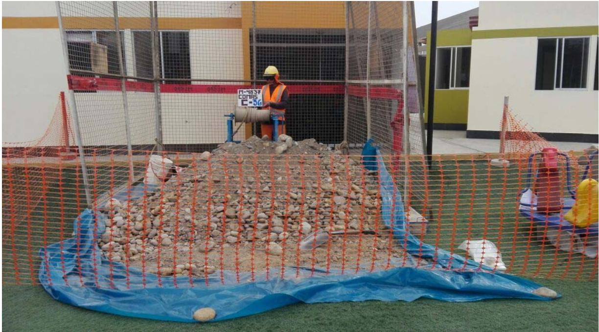
CALICATA C-36. SE APRECIA EL EQUIPO UTILIZADO PARA EXTRAER LOS SUELOS DE LA EXCAVACIÓN Y EL MATERIAL GRAVA ARENOSA EXTRAÍDA.
