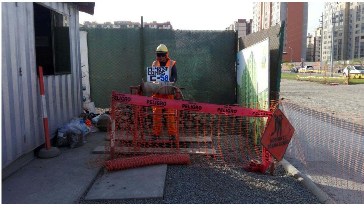
CALICATA C-58. SE OBSERVA EL EQUIPO UTILIZADO PARA EXTRAER LOS SUELOS DE LA EXCAVACIÓN.
